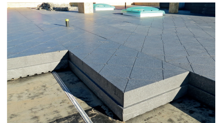
Zuschnitt der Dämmplatten mit Heißdraht
