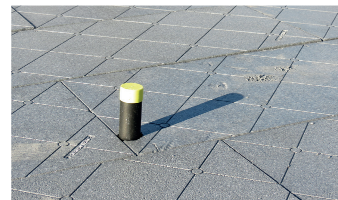
Feuchtigkeits-Flächensensoren verlaufen unter strukturierten Dämmplatten
