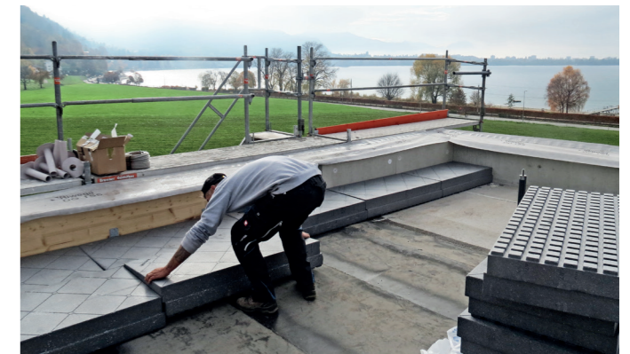
Verlegung der Dämmstoffe
