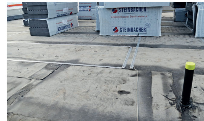
Feuchtigkeits-Monitoring bereits verlegt und Dämmstoffe angeliefert
